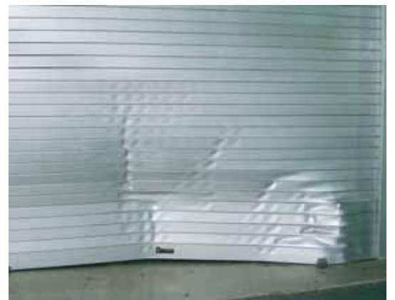
Imagen real después de un alunizaje contra una puerta modelo MASTER BLIND
